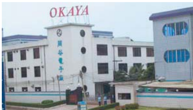
東莞東坑岡谷電子廠 (岡谷香港有限公司)
