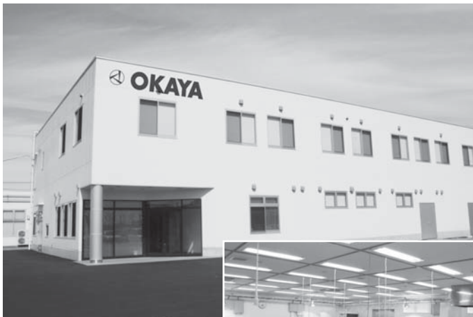
サージ試験棟 (埼玉県行田市)
