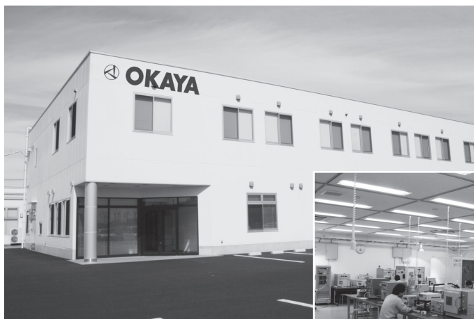
サージ試験棟(埼玉県行田市)
