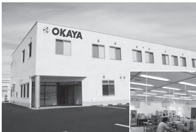
サージ試験棟(埼玉県行田市)
