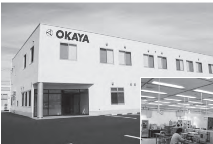
サージ試験棟(埼玉県行田市)
