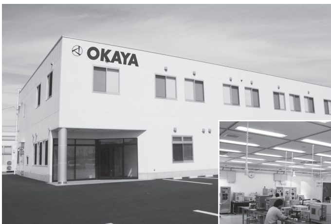
サージ試験棟(埼玉県行田市)
